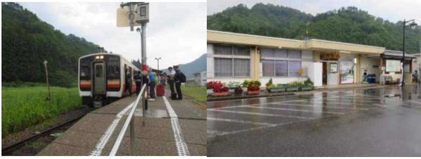
※只見駅（雨あり）
